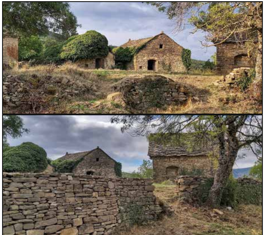
Antes y después de levantar las paredes de nuevo
