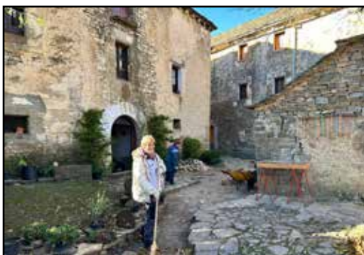
Tareas de reconstrucción y mantenimiento
