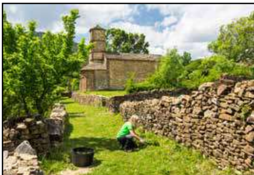
Tareas de reconstrucción y mantenimiento
