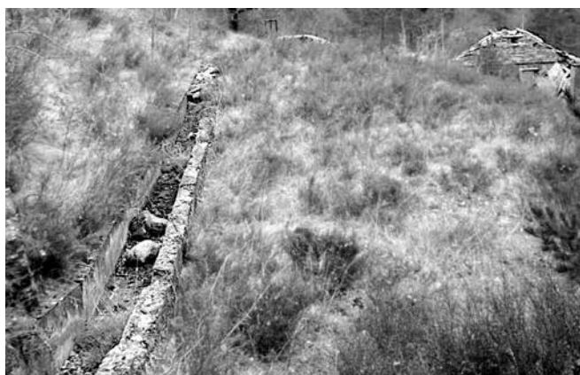
Canalón que suministra el agua
