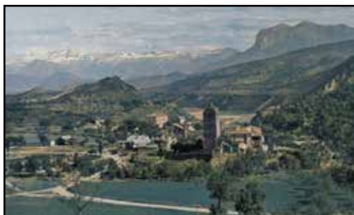
Mediano antes de la inundación
