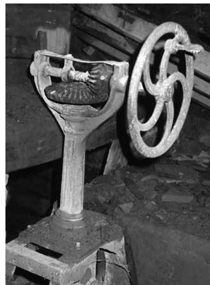
Controlador de turbina
