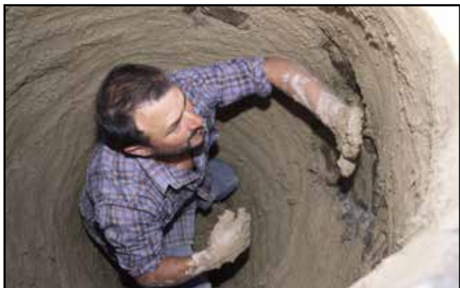
Preparando el interior del horno
